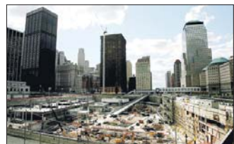
Las nuevas Torres gemelas en construcción
